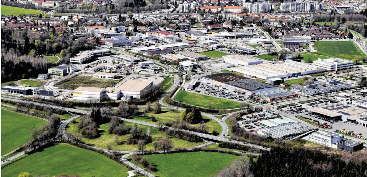
Der B12-Verteilerkreis bei Kaufbeuren soll im Zuge des Ausbaus in seiner Grundform beibehalten werden. Laut Thomas Hanrieder vom Staatlichen Bauamt Kempten muss er allerdings ertüchtigt werden, um in Zukunft eine größere Zahl an Fahrzeugen aufnehmen zu können. Foto: Harald Langer
